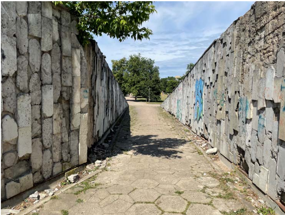
Pav. 2 Atraminių sienučių apdailos pažaidos
