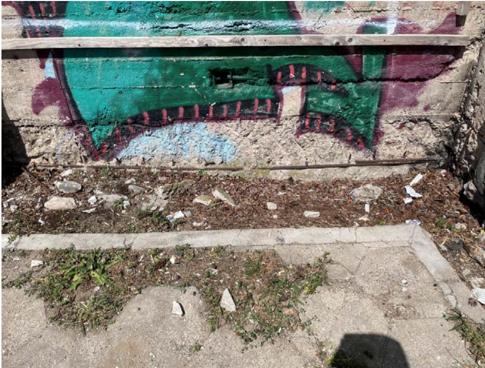
Pav. 6 Atraminių sienučių armatūros apsauginio betono sluoksnio, apdailos pažaidos
