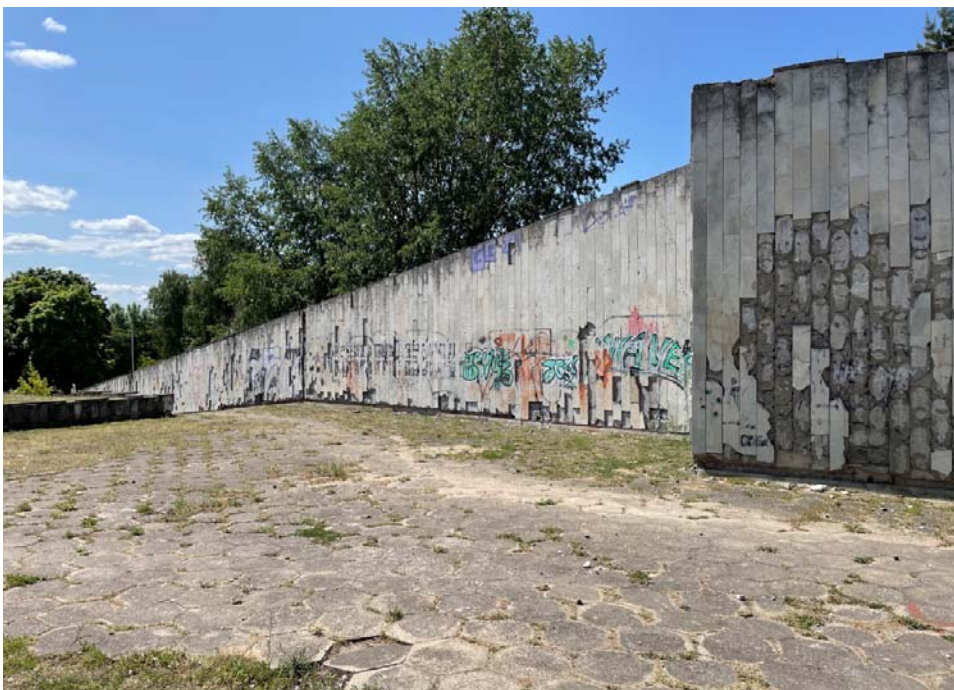
Pav. 3 Atraminių sienučių apdailos pažaidos
