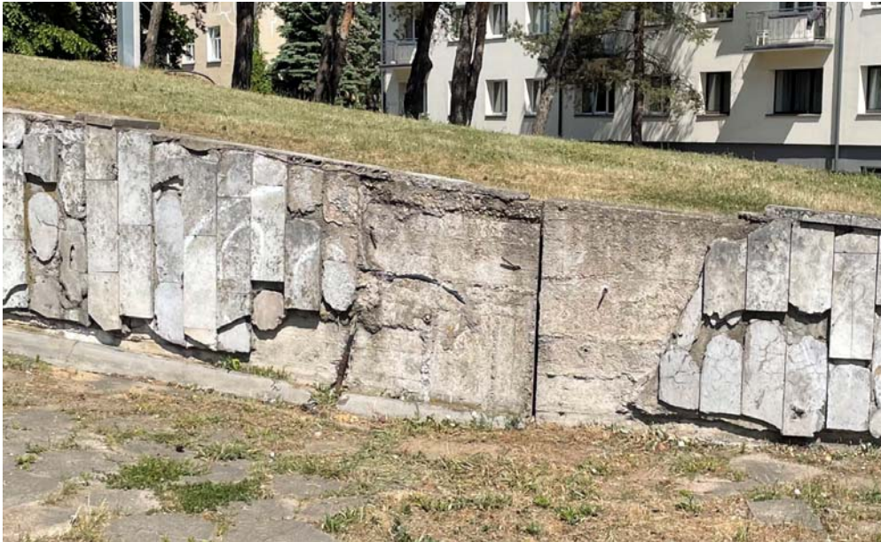
Pav. 4 Atraminių sienučių deformacinė-temperatūrinė siūlė, apdailos pažaidos
